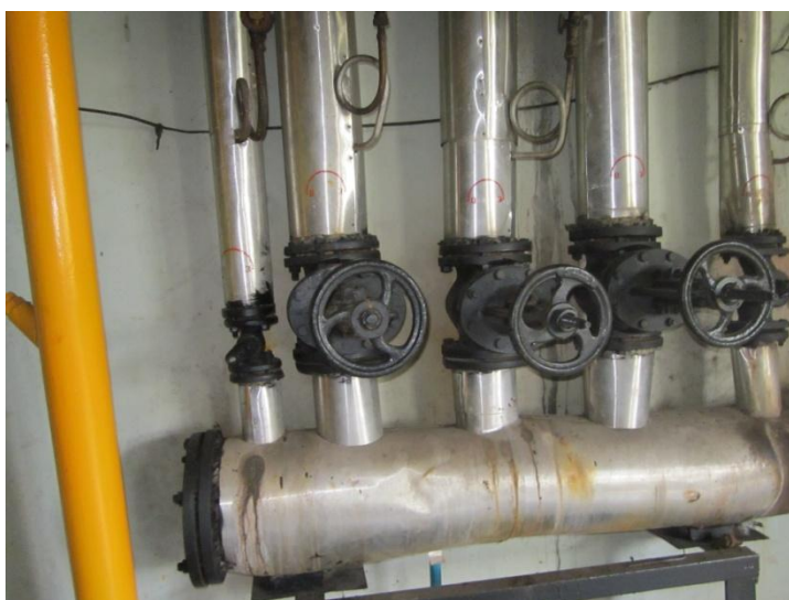
Рисунок Распределительный узел котельной ЦРБ.
